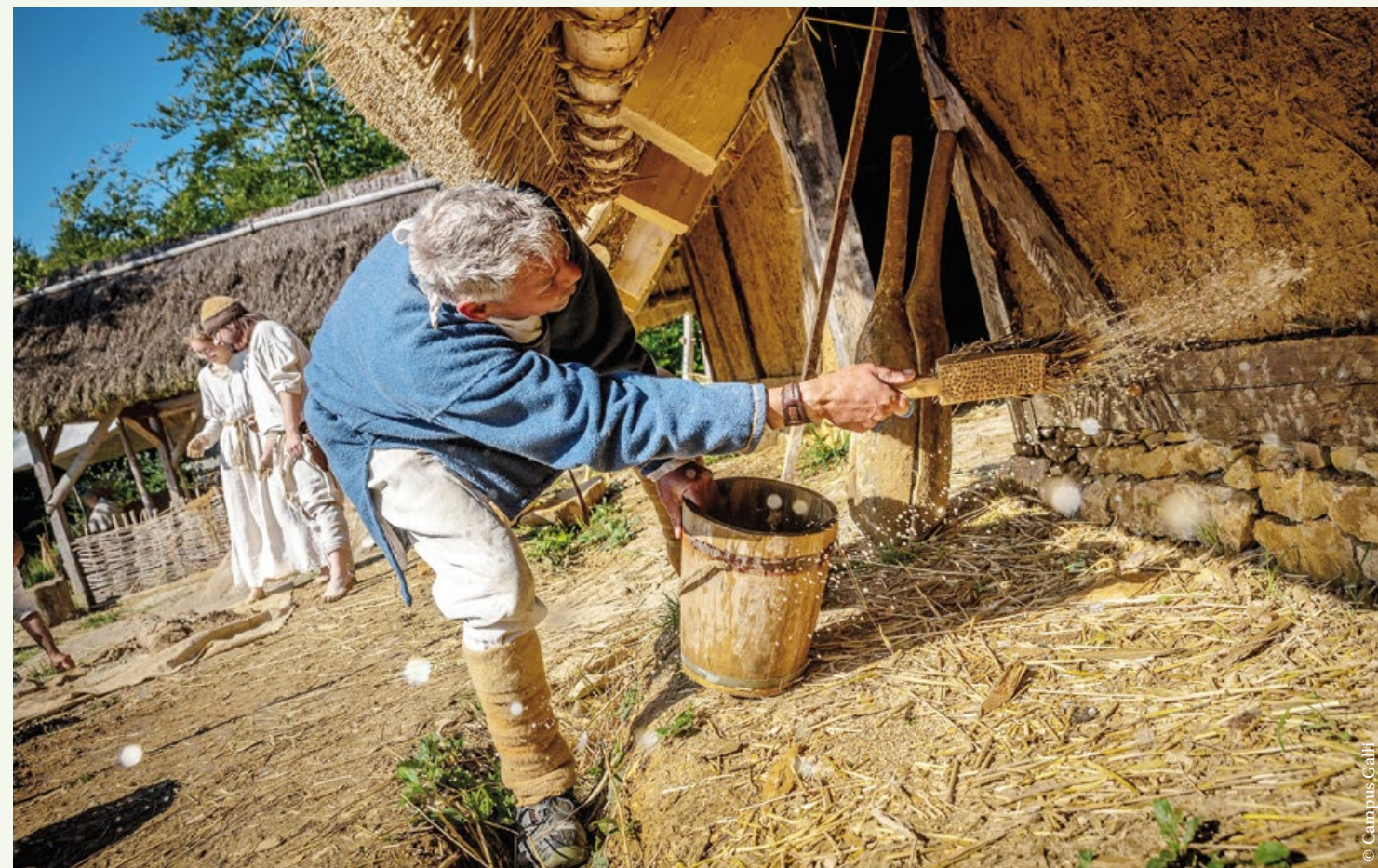
An der Scheune entsteht eine Lehmwand.
