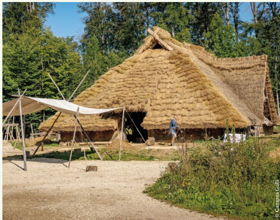
2021 wurde die große Scheune fertiggestellt.
