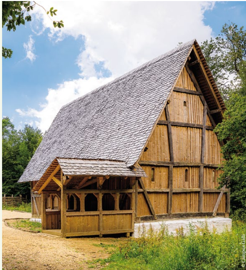
Die Kirche steht bereits.
