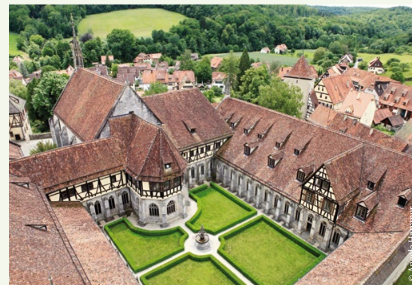
Innenhof mit dem herausragenden Brunnenhaus und Kreuzgang.
