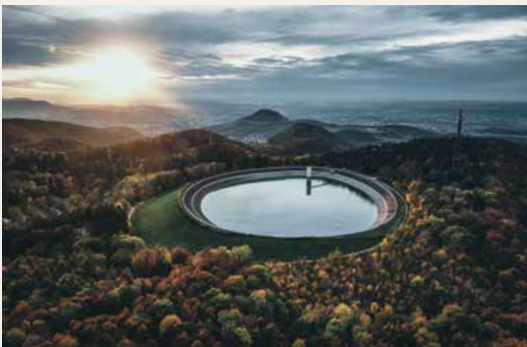
Oberes Becken Pumpspeicherkraftwerk Glams, Lars Unruh (s. auch Seite 46)
