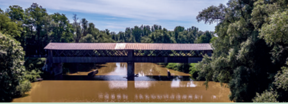
Rott-Brücke, Neuhaus a. Inn.
