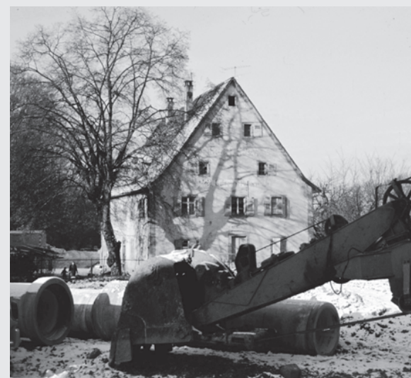
Kaiser-Mühle vor dem Abbruch - Photo: W. Glaubrecht
