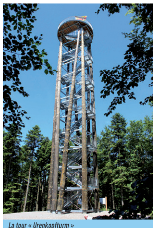
La tour « Urenkopfturm »
