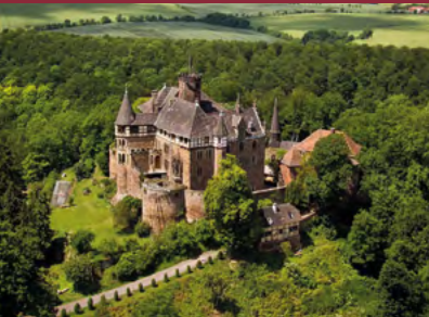
Gratis toegang tot het slotplein
