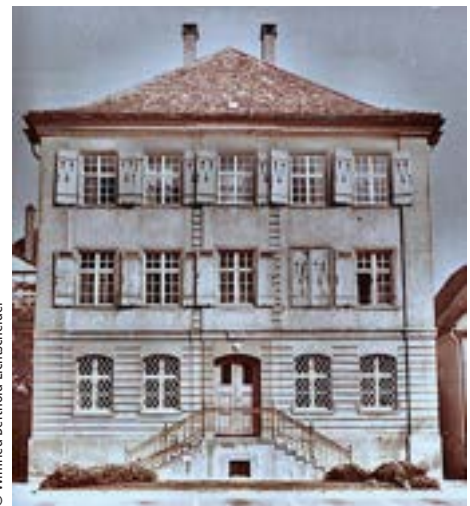
Das ehemalige Pfarrhaus vor der Renovierung
