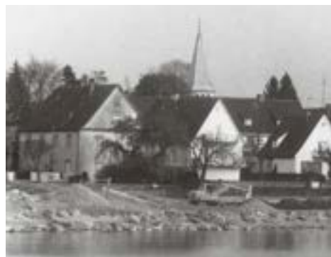
Alte Ansicht des mittleren Uferbereichs während der Bauarbeiten in den 70er Jahren.
