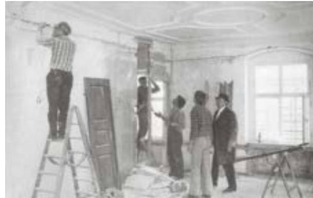
Renovierungsarbeiten der freiwilligen Helfer aus heimischen Handwerkern und Bürger von Langenargen
