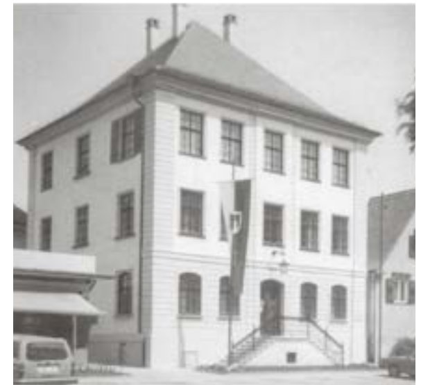
Das ehemalige Pfarrhaus nach der Renovierung
