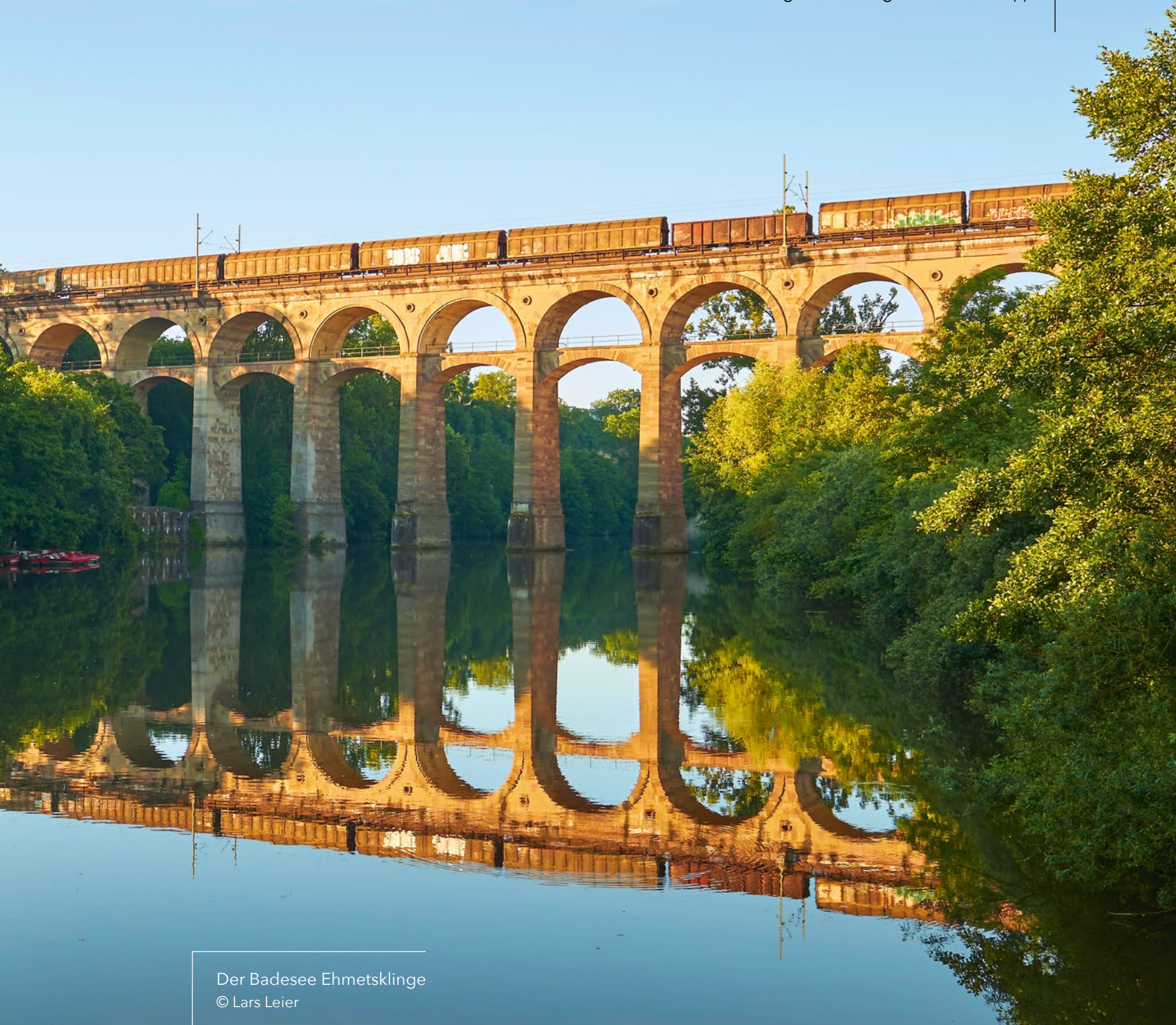
Das Enzviadukt bei Bietigheim-Bissingen © Ulrike Klumpp
