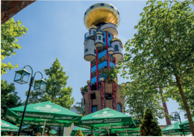
Kuchlbauer Turm – ein Hundertwasser Architekturprojekt, geplant und bearbeitet von Architekt Peter Pelikan ©Gruener Janura AG, Glarus, Schweiz ©Foto: Brauerei zum Kuchlbauer GmbH & Co. KG
