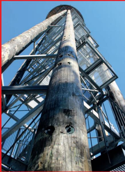
Das Turmbauwerk besteht aus vier senkrechten Hauptstützen aus Douglasienstämmen, beidseitig ergänzt durch ein V-förmig angeordnetes Strebenpaar ebenfalls aus Douglasienstämmen. Die Stämme sind in einer 90 cm dicken Stahlbetonfundamentplatte eingespannt. Aufgrund der Turmhöhe sind die Stämme auf ca. 2/3 der Höhe gestoßen. Die Stämme sind mit Horizontalrahmen und Diagonalverbänden aus feuerverzinktem Stahl verbunden und aus-
