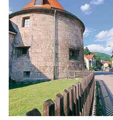
Bad Urach, Dicker Turm
