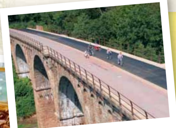
Klausmarbacher Viadukt eine 32 m hohe Sandsteingewölbebrücke
