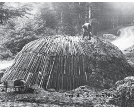
Kohlemeier im Bau
