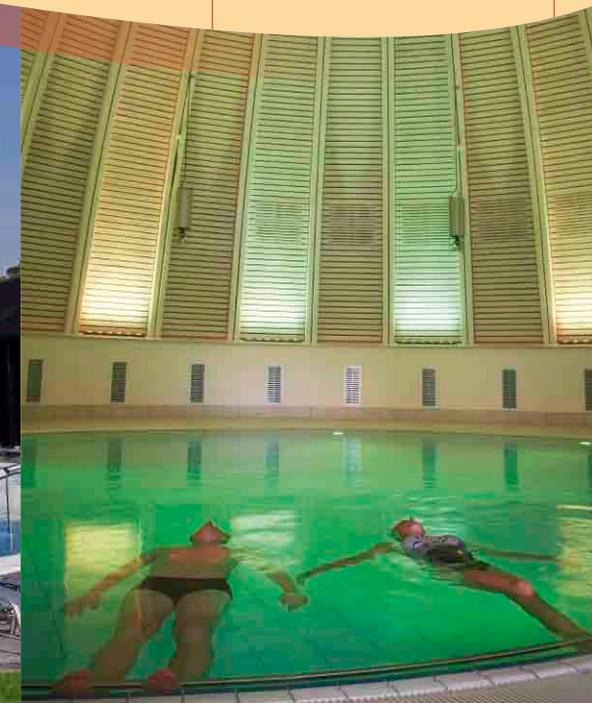
Die futuristische Bauweise der Thermen- und Saunalandschaft ist ein weiteres Wiedererkennungsmerkmal des Kurortes. Die imposante Dachkonstruktion der Toscana Therme wurde komplett aus Holz gefertigt und besteht aus 750 Elementen.
