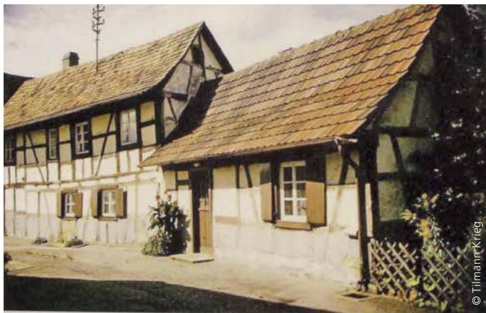
Ehemaliges „Weberhäuschen“ in Winkel – Erbaut 1818, Abbruch 1996
